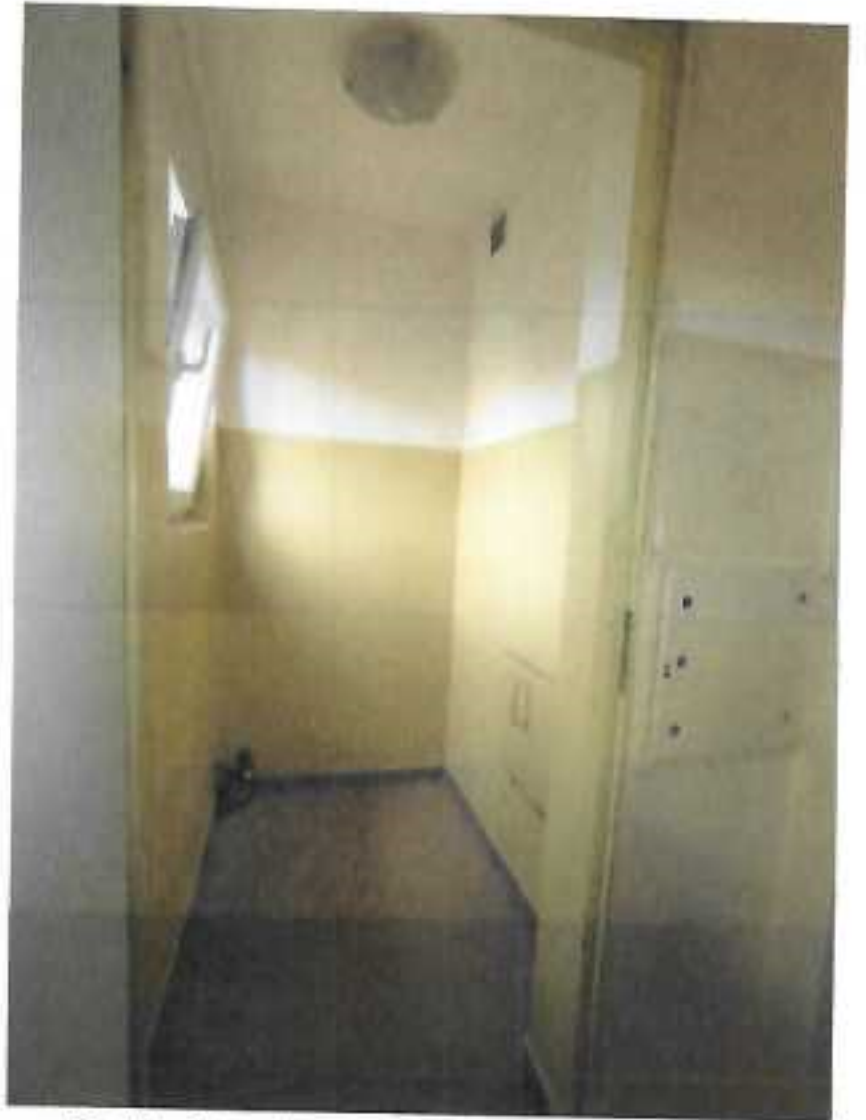
Fot 9. Pomieszczenie zsypu na kondygnacji Powtarzalnej
