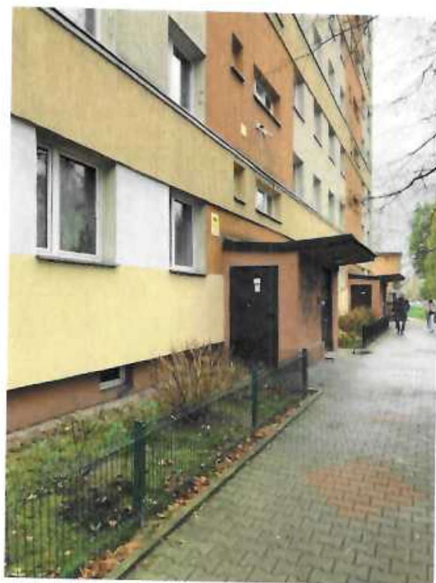
Fot 4,5. Widoki elewacji bocznych wiatrolapu
