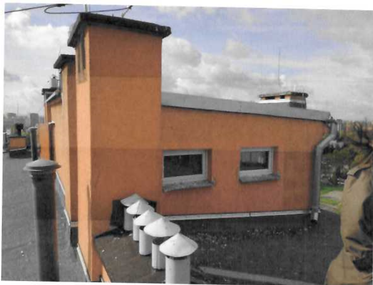
Fot 13. Obudowa maszynowni na dachu
