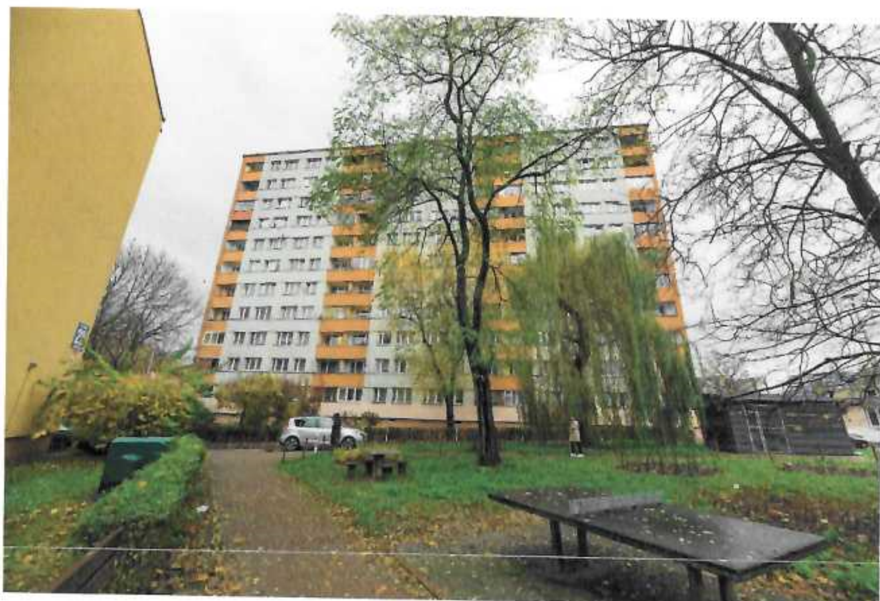
Fot 2. Budynek – elewacja tylna
