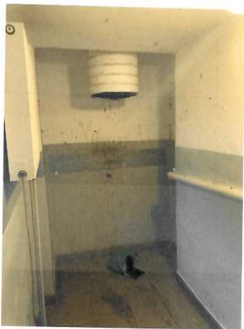
Fot 8. Wnętrze wiatrolapu- pomieszczenie zsypu
