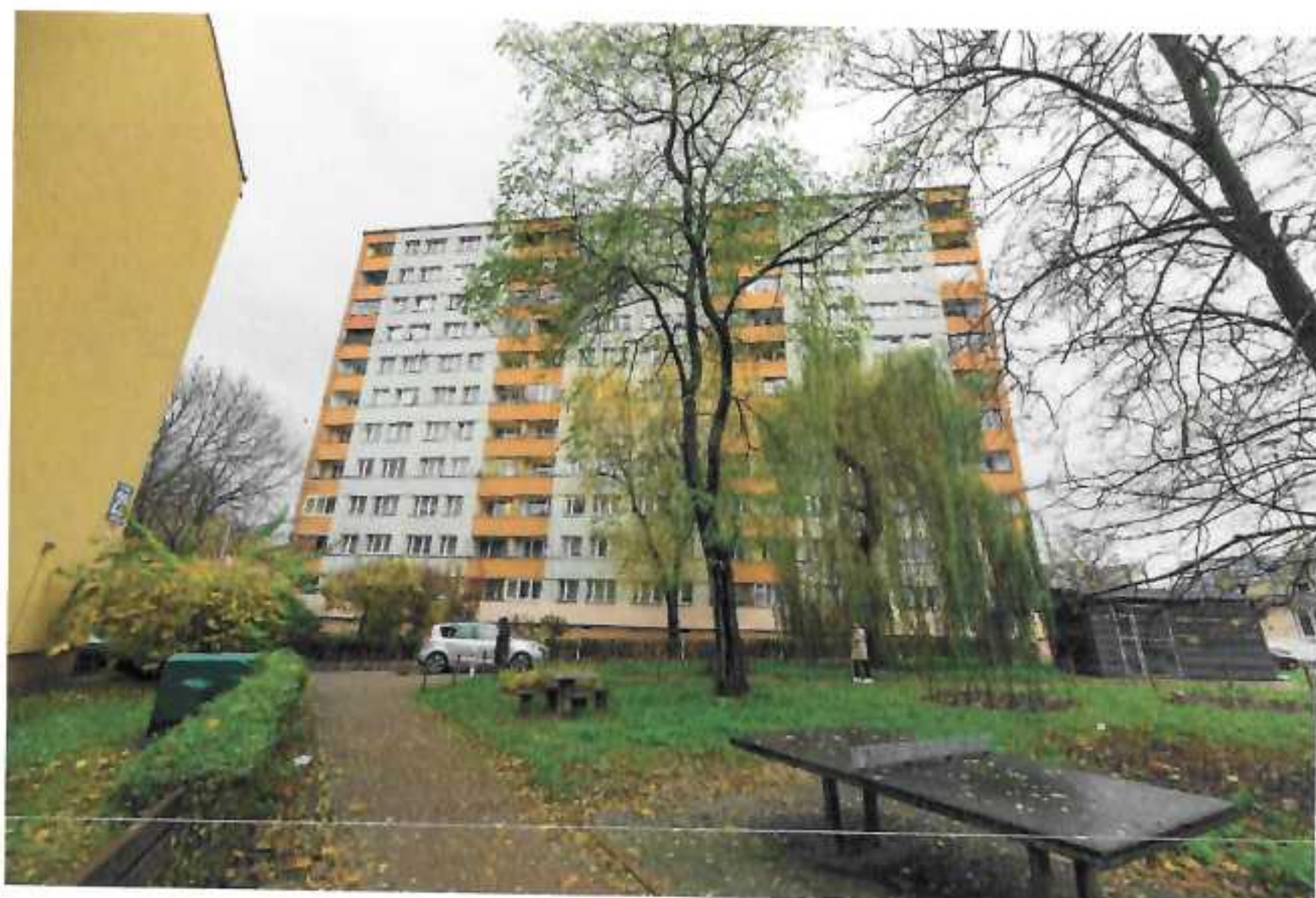
Fot 2. Budynek – elewacja tylna
