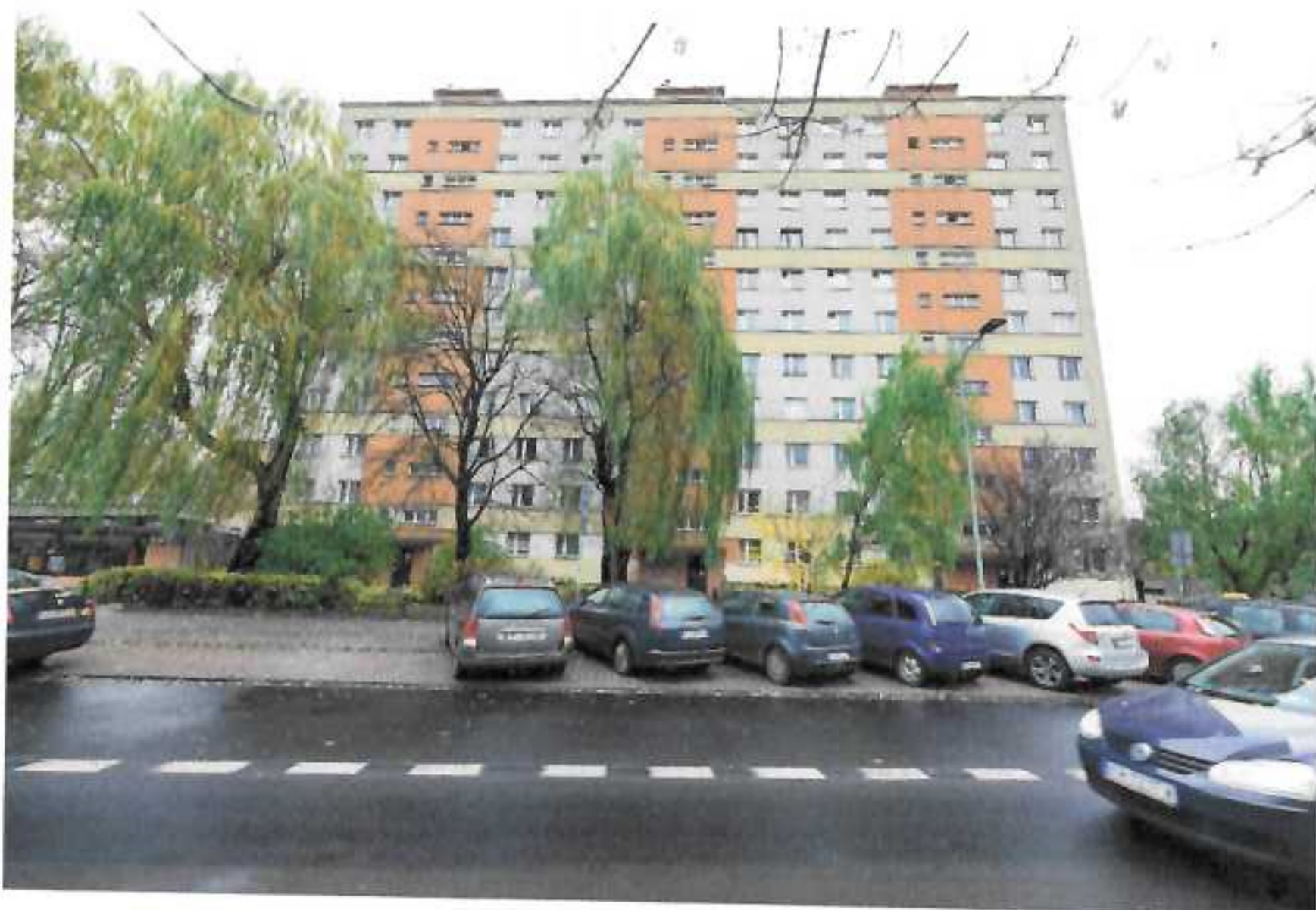
Fot 1. Budynek – elewacja frontowa
