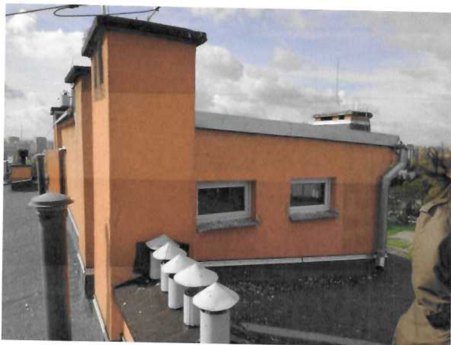
Fot 13. Obudowa maszynowni na dachu
