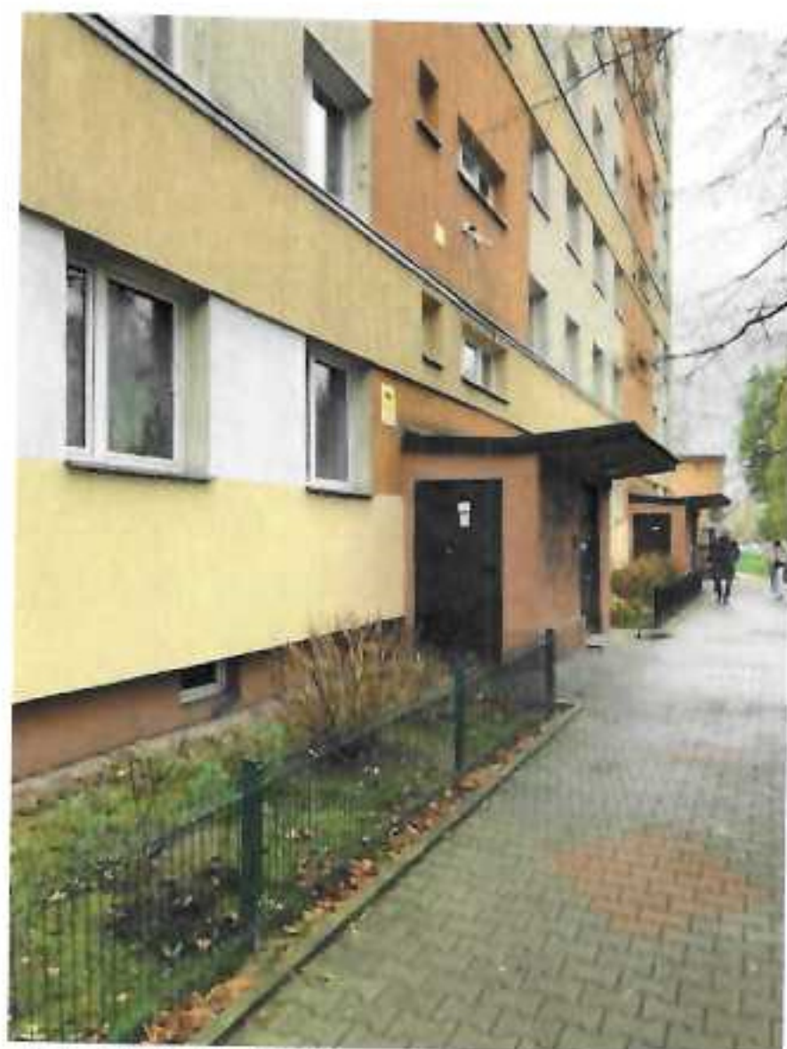
Fot 4,5. Widoki elewacji bocznych wiatrolapu
